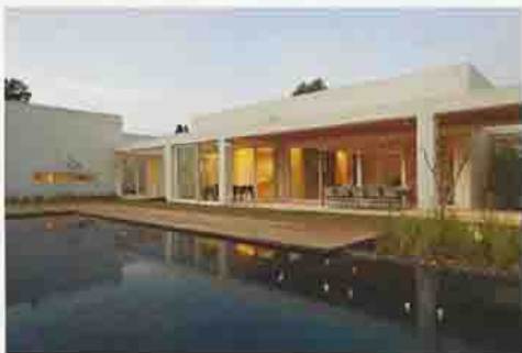
בית פרטי חד קומתי, המושפע במעברים שקופים המתברים בין אגפי הבית ויוצרים הרמוניה עם החוץ. שטח מגרש: 3,000 מ"ר, שטח בנוי: 450 מ"ר (צילום: עמית נרון)
